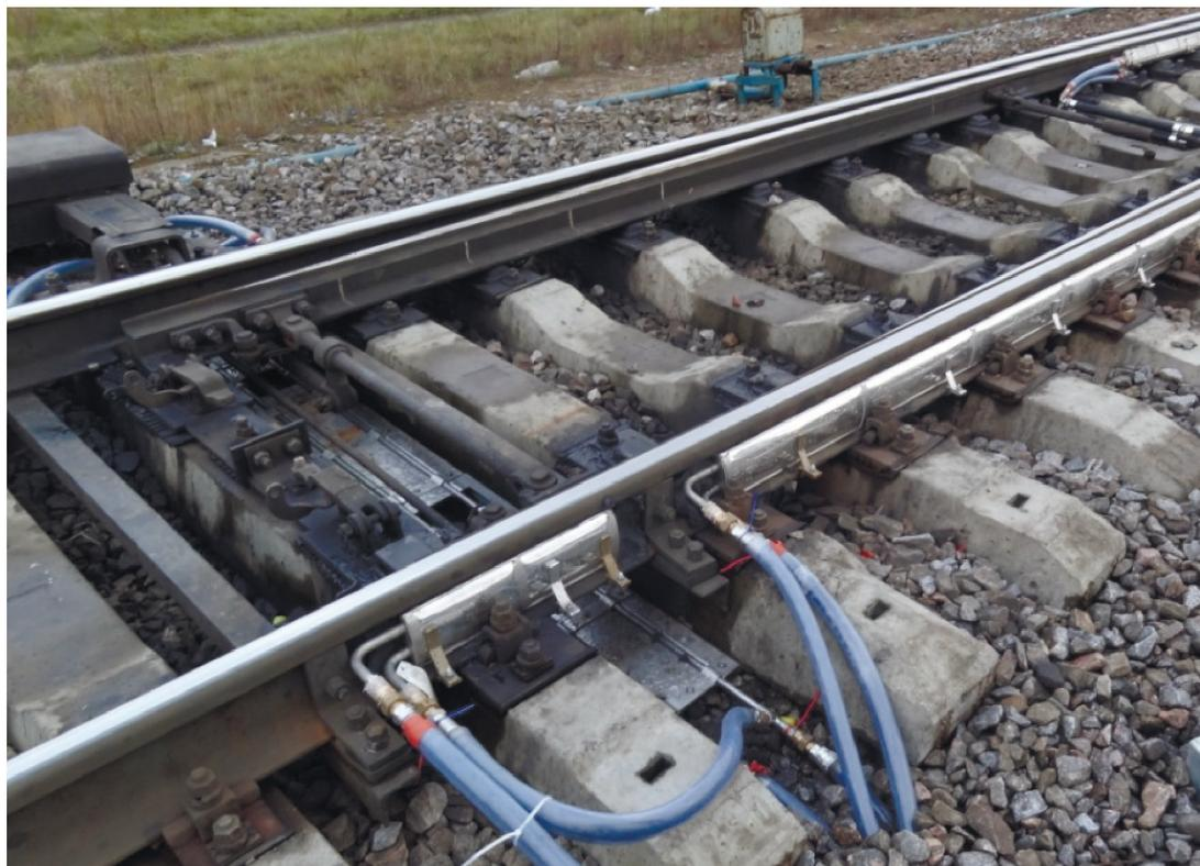
Рис. 27. Система геотермического обогрева стрелочного перевода
